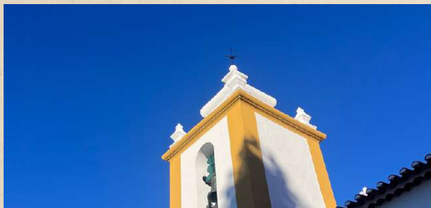
Torre da Igreja de Belver
